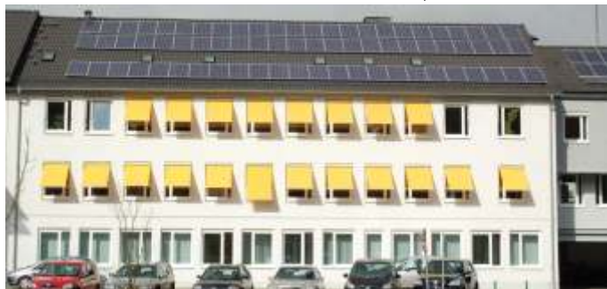
Auch auf dem Dach des Morsbacher Rathauses wird Sonnenenergie in Strom umgewandelt. Foto: C. Buchen
