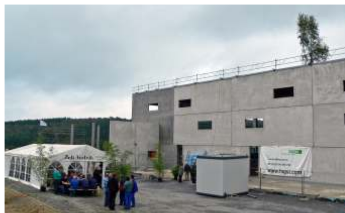
Auf dem Dach der 11 Meter hohen neuen Werkshalle der Fa. FAGSI in Lichtenberg stand der Birkenbaum, als geladene Gäste und Arbeiter das Richtfest feierten.
