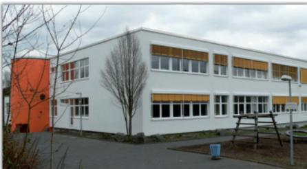
Die Fassade des in den 1970er Jahren errichteten Grundschulgebäudes an der Hahner Straße wurde kürzlich grundlegend saniert. Dabei wurden auch die Fenster, Türen und Sonnenschutzanlagen erneuert. Die bisherige Schieferplattenfassade erhielt ein neues Wärmedämmverbundsystem. Die Kosten der Maßnahme betragen ca. 400.000 Euro.
