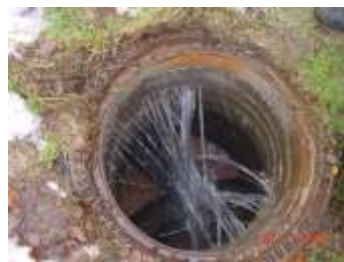
Fremdwasserzufluss in einem Kanalschacht
