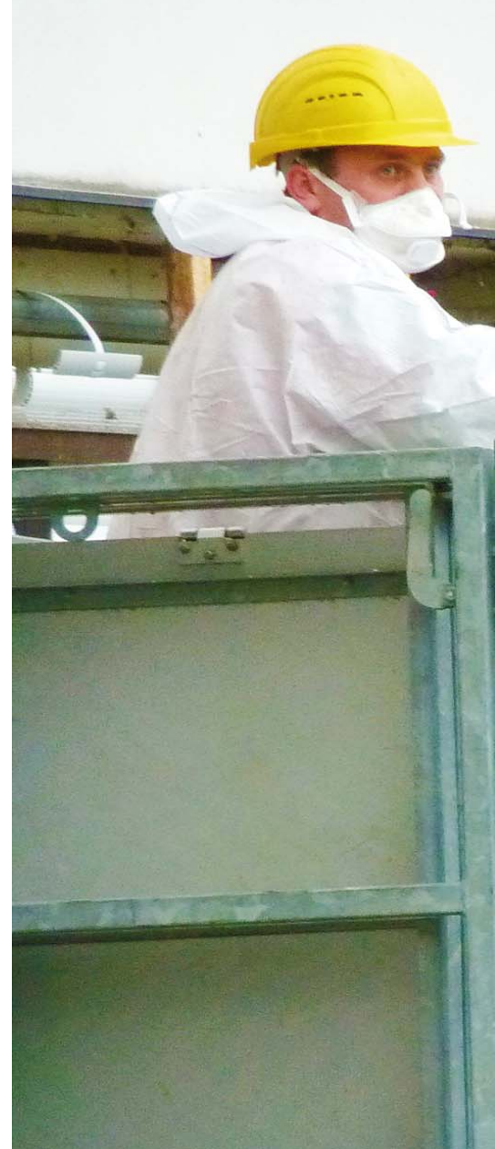
Arbeiter bei der Asbestsanierung eines Gebäudes
