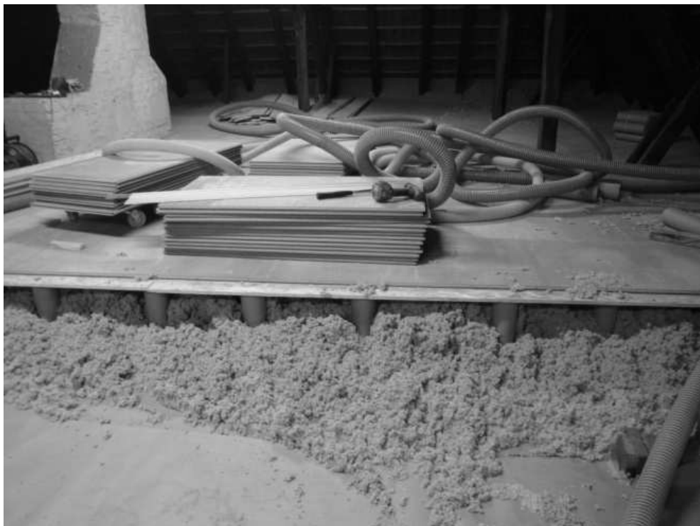
Abbildung. 3.3.1: Traghülsen-Konstruktion
