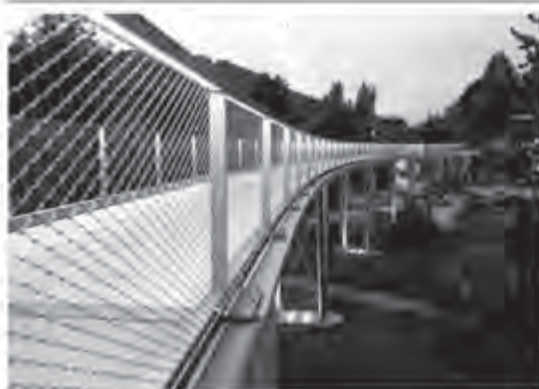
Textil-Betonbrücke in Allstadt (Foto: Institut für Massivbau)
