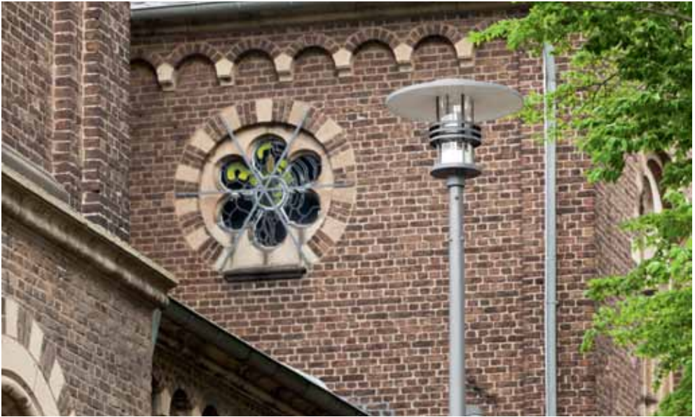
Dieser Leuchtentyp wurde an der Kirche als Sonderform eingesetzt.
