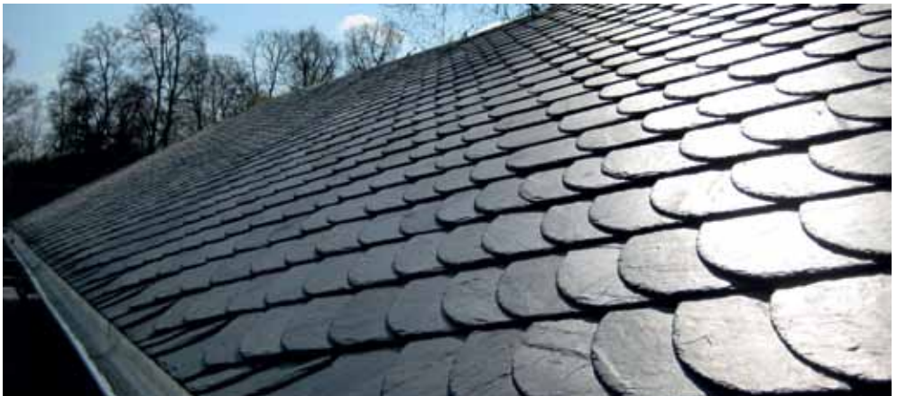
Das neue Schieferdach in Nahaufnahme
