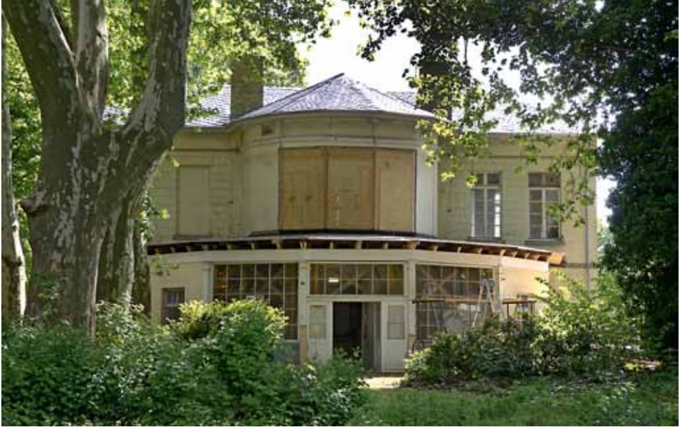
Die Westfassade von Bahnhof Belvedere mit erneuertem Dach
