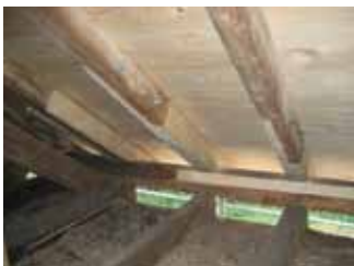
Erneueres Tragwerk im Treppenhaus-Dach und instandgesetzter Dachstuhl des Walmdachs
