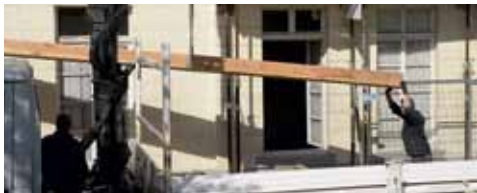
Seite 14 | Dachsanierung Bahnhof Belvedere
