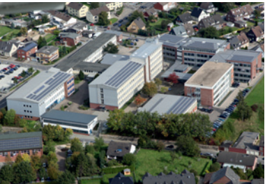
Rurtal-Schule (oben) und Berufskolleg Geilenkirchen: zwei Standorte der neuen Fotovoltaikanlagen
