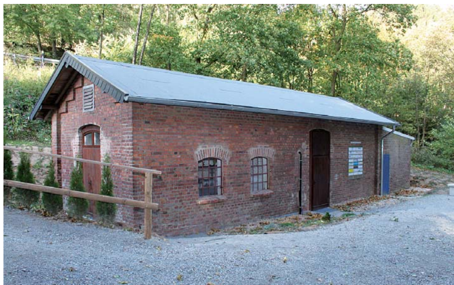
Historisches Pumpenhaus – ehemals Pumpenhaus der Reichsbahn in Marienheide
