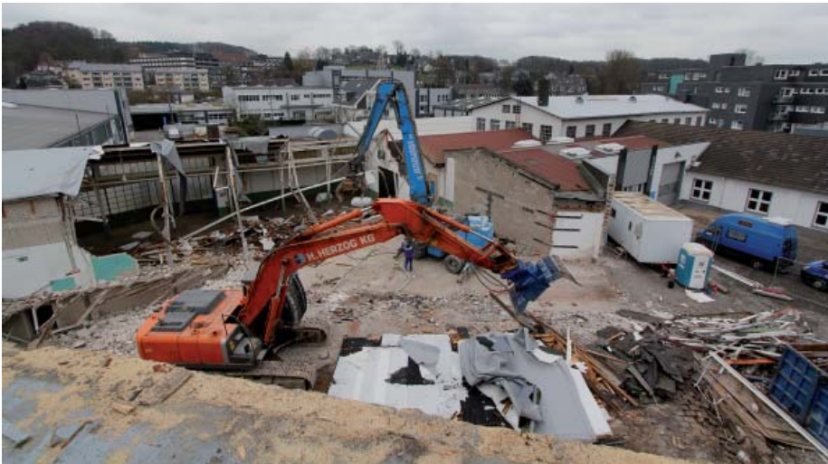
Baustelle im Januar 2014
