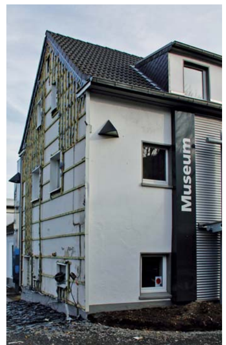
Baustelle Museum im Januar 2014
