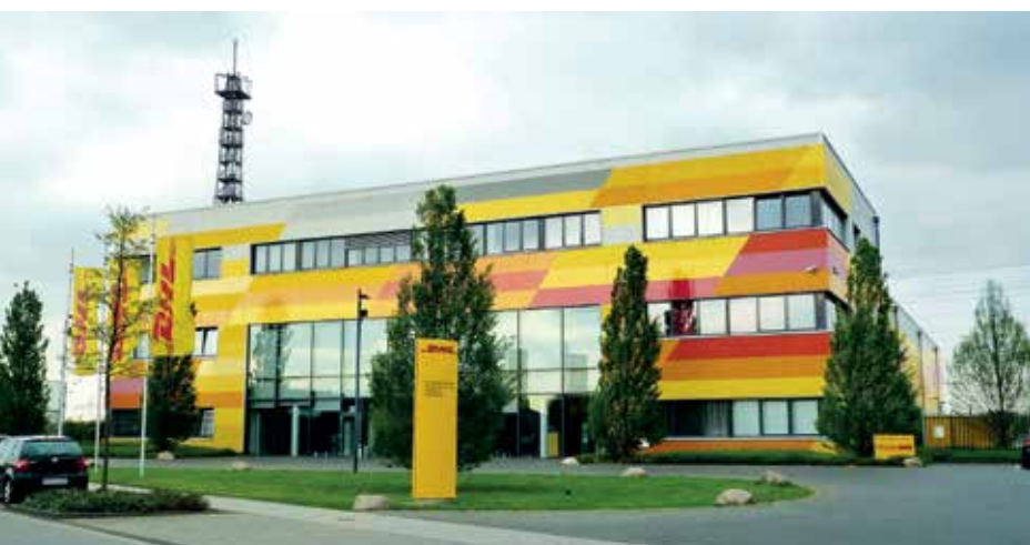
DHL-Innovation Center: Kommunikationsplattform zur Förderung von Wissensaustausch zwischen Wissenschaft, Wirtschaft und Technik sowie zur Entwicklung neuer Logistiklösungen. Foto: Gregor Lackmann, BBSR
