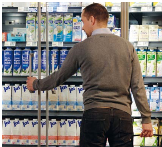
Durch Glastüren vor den Kühlregalen lassen sich 20 bis 40 Prozent Strom einsparen.
