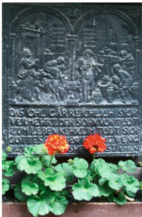
Solche gusseisernen Ofenplatten wurden noch im 19. Jahrhundert. in den Wohnhäusern zur Wärmespeicherung genutzt. Sie waren hinter der offenen Feuerstelle der Diele in der Wand eingelassen, speicherten die Wärme und gaben diese in den Wohnraum dahinter ab. Es waren Kunstwerke der Eisenverarbeitung.
