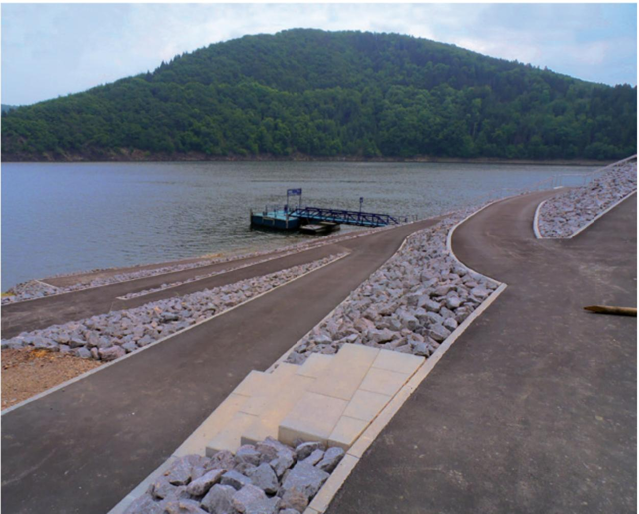
Weitere Beobachtungen im Umfeld der zum Kraftwerk führenden Schwerlastzufahrt und des über der o.g. Spundwand befindlichen Kranaufstellplatzes wiesen einen Versatz des Zufahrtweges zur Rurseite auf.
