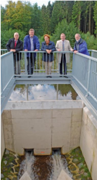
halb liegenden Wiese abgetrennt. Der vorhandene Damm wurde erneuert und es wurde ein Auslaufbauwerk aus Stahlbeton eingelassen, das auch über eine integrierte Hochwasserentlastung verfügt. Das Auslaufbauwerk drosselt heute den Omerbach von einem rechnerischen Wasserzufluss von  $1,95 \text{ m}^3/\text{s}$  beim HQ 100 auf einen Abfluss von maximal  $1,0 \text{ m}^3/\text{s}$ .
