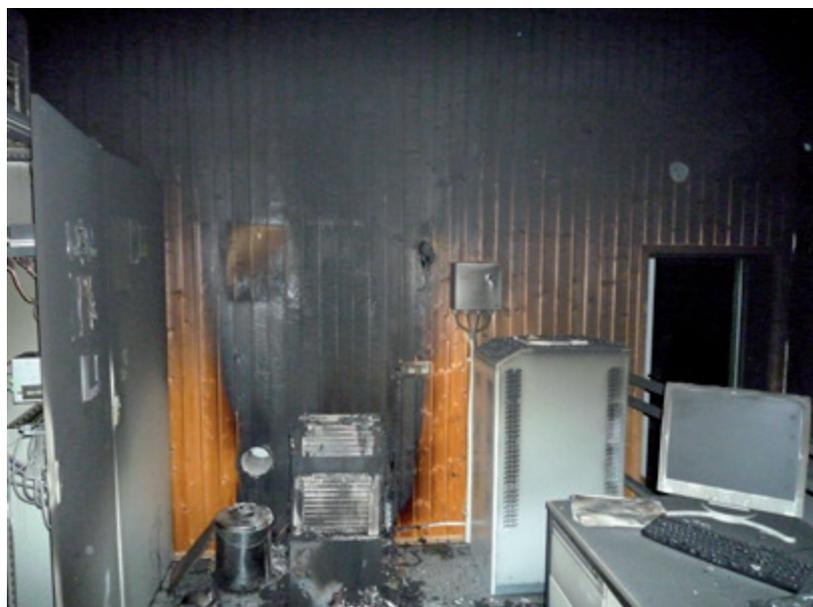
*Ausgebrannte Schaltanlage auf der Kläranlage Steinbusch*
