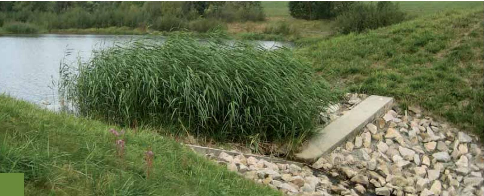
*Absenkung der Stauziele durch Errichtung einer tieferliegenden, überströmbaren Dammscharte*
