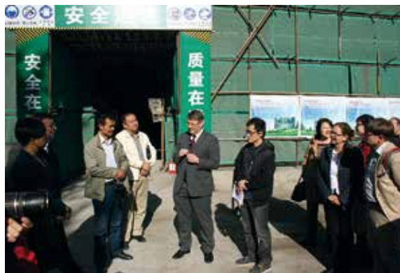
Baustelle des Passivhauses: Eine Begehung mit Vertretern der Stadt Urumqi, der deutschen Botschaft, des Projektträgers im DLR und weiteren Projektpartnern.
