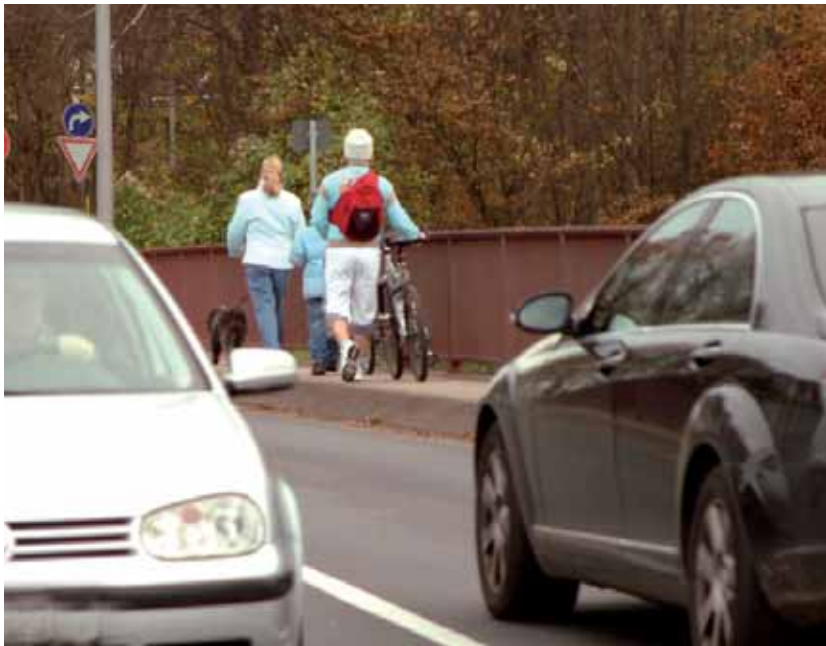
Die für Fußgänger und Radfahrer lebensgefährliche Brücke über die Autobahn
