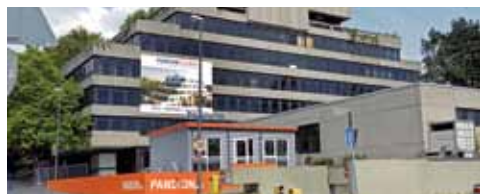
Seite 9 - Neuorientierung an der Terrassenkante
