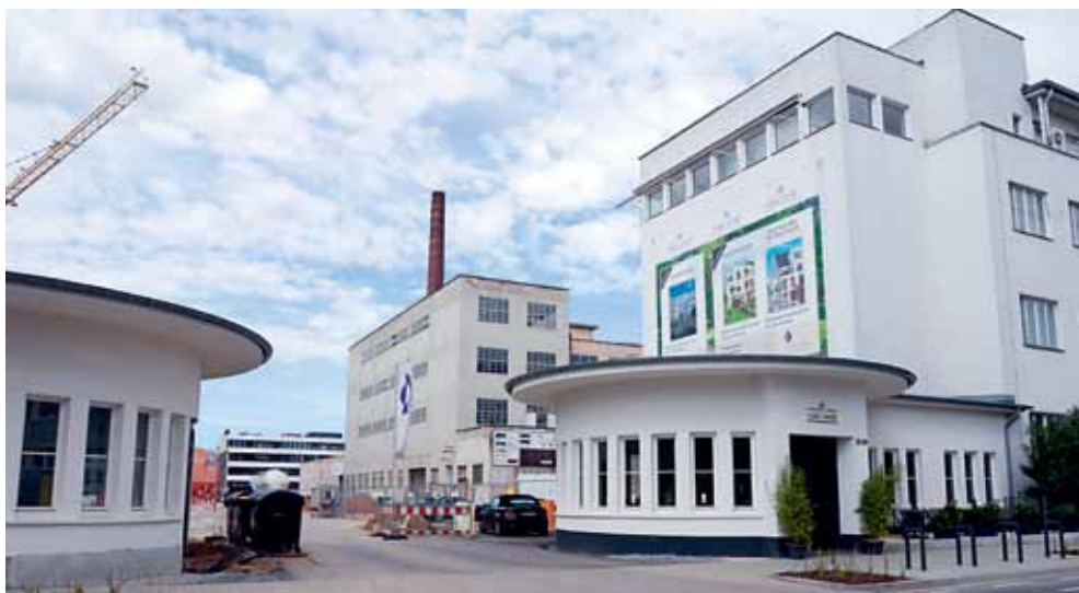
Pförtnerhäuschen der Sidol-Werke, erbaut 1949
