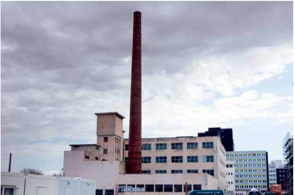
Was bleibt: Denkmalschutz für das Sidolgebäude von 1926
