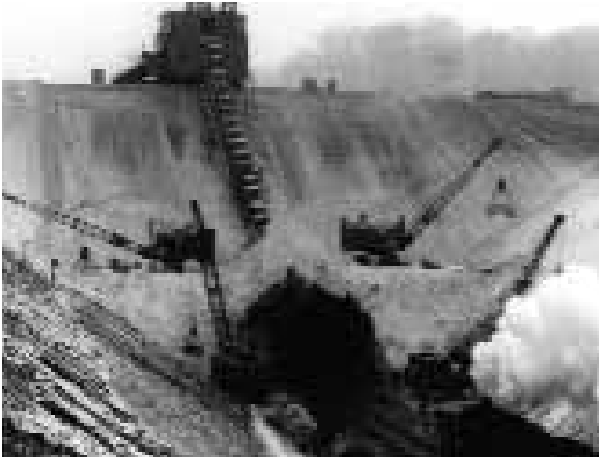
Der Tunnel wird aufgeschlitzt
