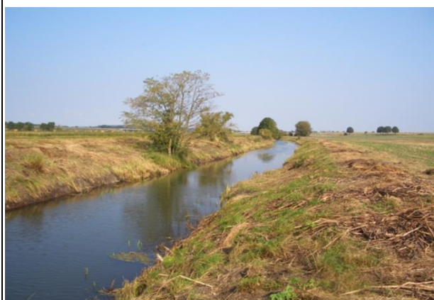
e) Der kanalisierte Unterlauf der Welse im Urstromtal.
