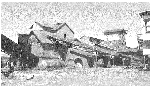
Historische Brechergebäude der Firma Adrian in Enspel
