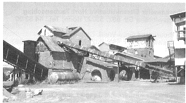
Historische Brechergebäude der Firma Adrian in Enspel
