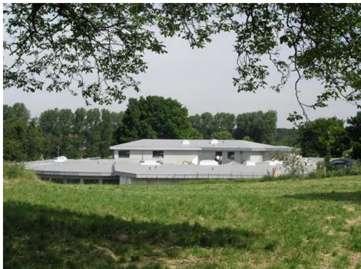
Abb. 6: Das neue Demenzheim in Frelenberg, an der Stelle der ehemaligen Volksschule gebaut. Foto: Stadt
