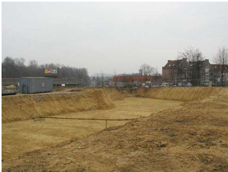
Abb. 3: Das geplante AWO-Seniorenheim entsteht. Hier noch die große Baugrube an der Carlstraße. Foto: Stadt
