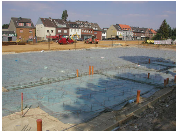
Abb. 10: Fast gleichzeitig entstehen in Boscheln (Plus-Markt) und Übach (Lidl am Wasserturm) zwei neue Supermärkte. Hier der noch fast "unbefleckte" Bauplatz des PLUS in Boscheln. Foto: Stadt
