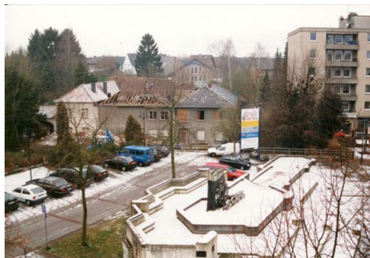
Abb. 2: Der Rathausplatz auf dem Wege zu einem neuen Gesicht. Ein weiterer Schritt: Abbruch des Hauses Küsters. Foto: Stadt
