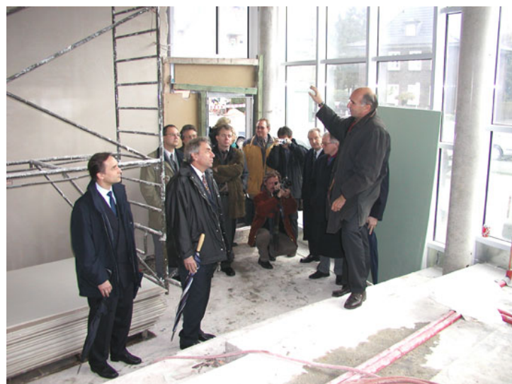
Abb. 16: RP Jürgen Roters zu Besuch in Übach-Palenberg. Er informiert sich vor Ort über den Stand der Bauarbeiten im geplanten Städt. Jugendzentrum. Foto: Stadt
