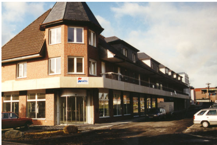
Abb. 17: Das neue Wohn- und Gewerbehaus an der Friedrich-Ebert-Straße in Übach. Ganz im Vordergrund das neue Domizil der Raiffeisenbank, welches im November eröffnet wurde. Foto: Stadt
