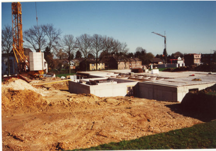
Abb. 7: Das Jahr 2000 gehörte u.a. dem Bau des Lebenshilfe-Wohnheims in Scherpenseel. Hier die fertigen Kellerräume. Foto: Stadt
