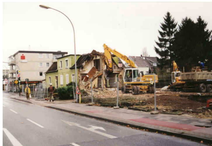
Abb. 18: Ein vertrautes Bild verschwindet durch den Abriss zweier Siedlungsblocks an der Roermonder Straße/Ecke Brünestraße in Boscheln. Foto: Stadt
