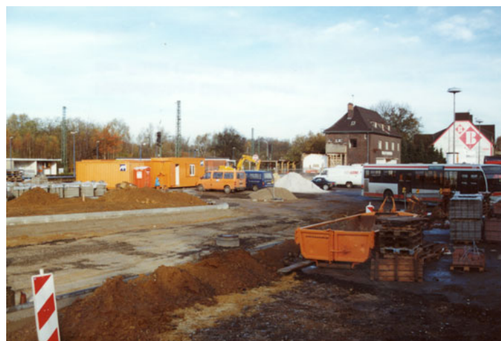
Abb. 19: Die Baustelle am Bahnhof im Dezember 2000. Foto: Stadt
