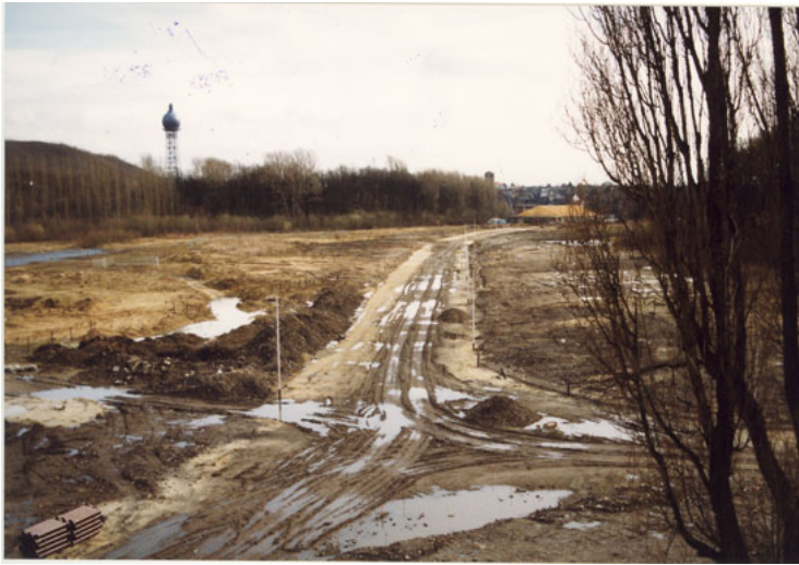
Abb. 5: "Baustelle des Jahres 1999": Die Straße über das ehemalige Zechengelände am Wasserturm. Noch sieht es "mondmäßig" aus. Foto: Stadt
