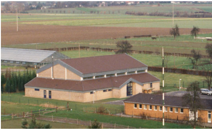
Abb. 5: Die neue Turnhalle der KGS Scherpenseel aus der Vogelperspektive. Foto: Stadt
