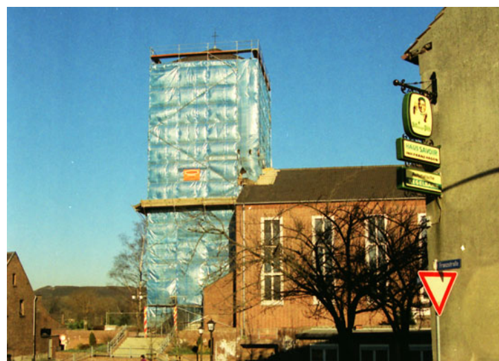
Abb. 3: Renovierung des Kirchturms der kath. Pfarrkirche in Übach. Also hier war nicht der "Verpackungskünstler" Christo am Werk, sondern ganz normale Handwerker. Foto: Stadt
