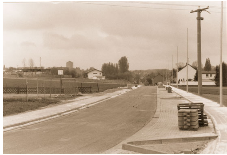
Abb. 5: Die verlängerte Talstraße nimmt Form an. Sie stellt damit eine gute Verbindung zur Boschstraße dar und ist demnach eine wichtige Erschließungsstraße für das Gewerbegebiet Weißenhaus. Foto: Stadt
