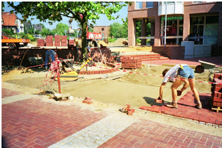
Abb. 10: Die Arbeiten im Rahmen der Pflasterung des Carlsplatzes liefen im Sommer 1991 auf vollen Touren. Foto: Stadt
