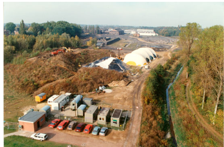
Abb. 13: Die Sanierung des ehemaligen Zechengeländes schritt auch im Jahre 1989 gut voran. U.a. musste verseuchter Boden (vom Kokereibetrieb) abtransportiert werden. Foto Stadt
