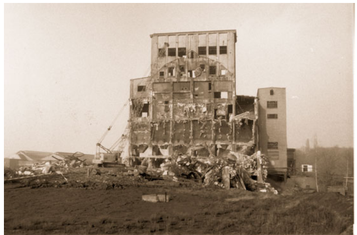
Abb. 3: Abriss der alten Kohlenwäsche auf dem ehemaligen Zechengelände Carolus-Magnus. Foto: Stadt
