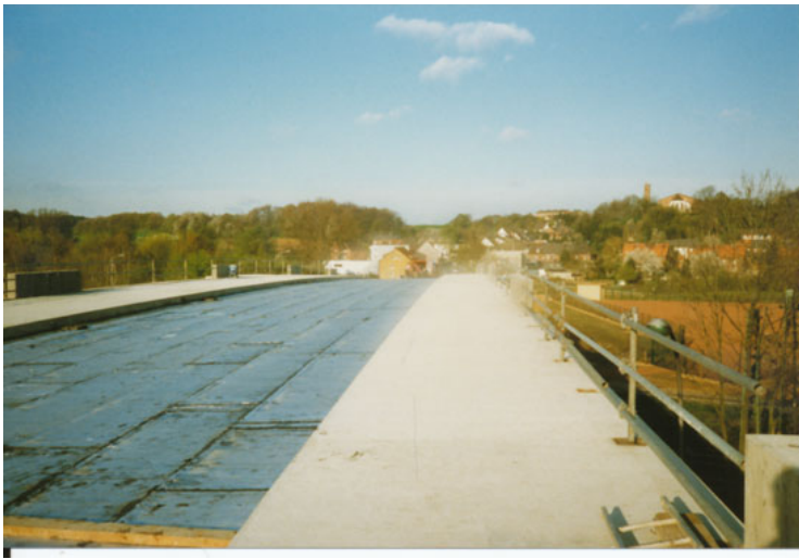
Abb. 7: Blick auf die Baustelle des neuen Brückenbauwerkes zwischen Palenberg und Marienberg. Bis der erste Verkehr fließt, wird es aber noch dauern. Foto: Stadt
