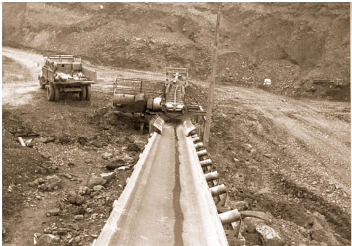
Abb. 8: Voller Betrieb auf der Carolus-Halde, um die noch vorhandenen Kohlebestandteile herauszuholen. Der Bergbau nach dem Bergbau ließ grüßen. Foto: Stadt
