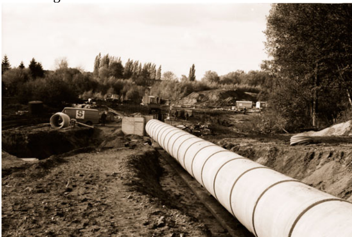
Abb. 1: Die Verrohrung des Übachs auf dem Carolus-Gelände sollte ein wichtiger Garant sein, dass im Falle eines starken Regenereignisses kein Hochwasser mehr auf dem Rathausplatz entstehen würde. Foto: Stadt
