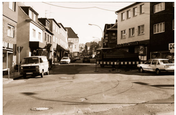
Abb. 3: Blick auf die Kirchstraße, die nach der Kanali-sation auf eine neue Straßendecke wartet. Foto: Stadt
