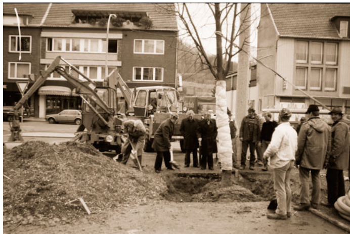
Abb. 3: Mit der Pflanzung der Linde auf dem Rathausplatz - in Erinnerung an die Lindenbaumtradition des früheren Lindenplatzes und jetzigen Rathausplatzes - begannen die Sanierungsarbeiten in Übach. Foto: Stadt
