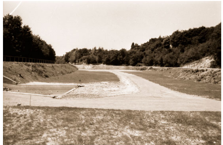
Abb. 2: Das neue Regenrückhaltebecken am Schroiffweg (Nähe Heidelberg) in unmittelbarer Nähe des Übach-Bettes nach der Fertigstellung. Foto: Stadt
