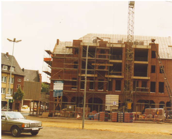
Abb. 6: Baustelle Rathausplatz. Hier entsteht im Jahre 1984 das neue Firmengebäude der Kreissparkasse. Foto: Stadt
