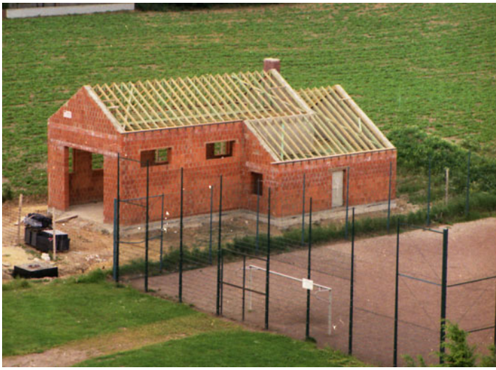
Abb. 11: Das entstehende Feuerwehrgerätehaus in Boscheln an der Martin-Luther Straße im Rohbau. Foto: Stadt
