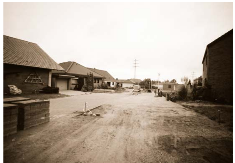
Abb. 6: Bautätigkeit in Frelenberg. Hier strebt der Ausbau der Schildstraße seinem Ende entgegen. Foto: Stadt
