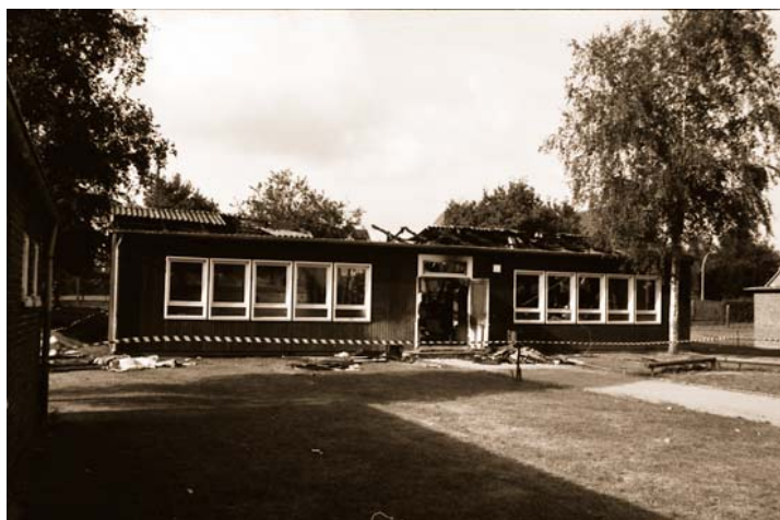
Abb. 14: Die an der GGS Boscheln gelegenen "Baracken"-Klassen aus Holz wurden durch einen Brand stark geschädigt. Foto: Stadt
