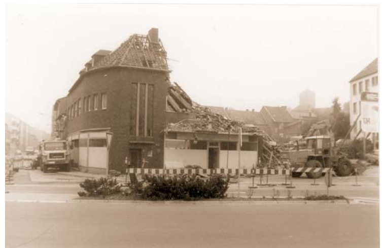
Abb. 12: Das Geschäftshaus von "Bohnen & Plum" am Rathausplatz wurde abgerissen. Hier soll die neue Kreissparkasse entstehen. Foto: Stadt
