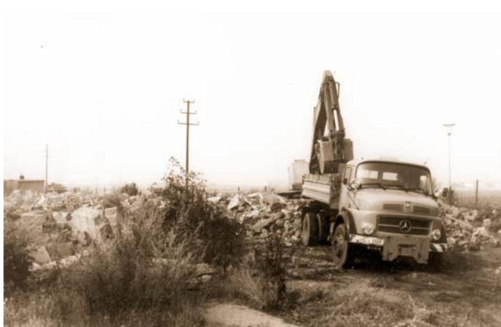
Abb. 11: Nur noch Trümmer auf der Höhe in Marienberg. Die heruntergekommenen Sozialwohnungen gehörten damit der Vergangenheit an. Foto: Stadt
