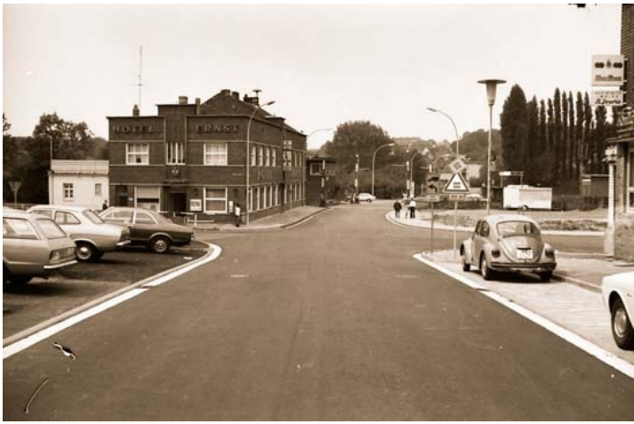
Abb. 11: Die neu ausgebaute Frankenstraße mit Blickrichtung Bahnübergang und Hotel Ernst. Foto: Stadt
