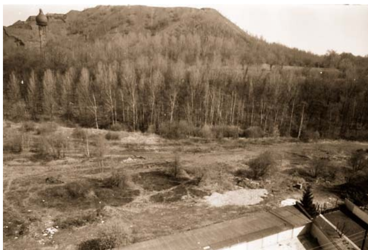
AAbb.10: Nach wie vor Bewegung auf dem Zechengelände Carolus-Magnus. Mit dem Jahre 1976 begann die Rückgewinnung von "Mittelgut" (d.h. Kohle mit Berge vermischt) auf Hochtouren zu laufen. Dadurch sollte das Haldevolumen erheblich reduziert bzw. aus einer 2-Kegel-Halde eine Gesamthalde werden. Foto: Stadt
