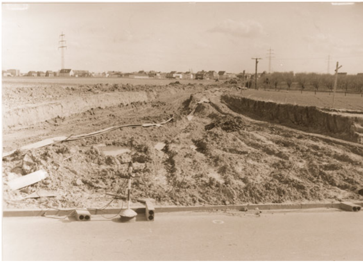
Abb. 4: ...zum anderen eine Erschließungsstraße im neuen Industriegebiet. Sie sollte eines Tages auf "Daimlerstraße" getauft werden. Fotos: Stadt
