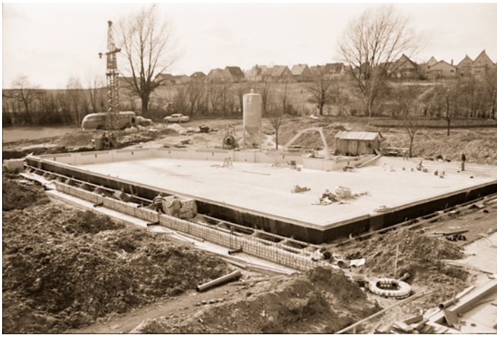
Abb. 3: Zwei Baustellen im März 1968, zum einen das neue Becken des Freibades...
