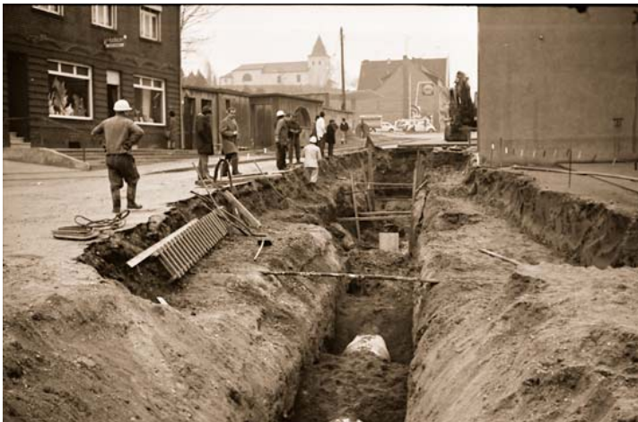
Abb. 17: Die Hauptdurchgangsstraße in Frelenberg war in diesen Tagen eine große Baustelle. Die notwendige Verlegung des Kanals war der Grund. Foto: Stadt
