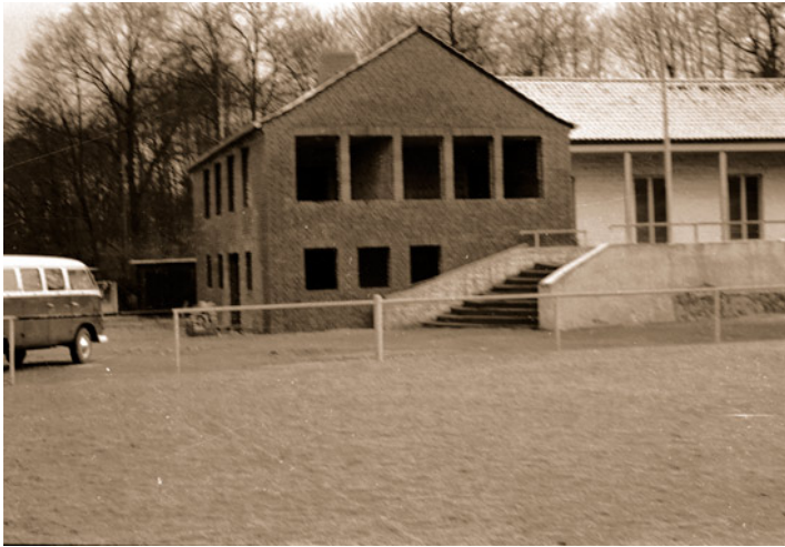
Abb. 1: Das neue Sporthaus im Stadion Übachtal im Rohbauzustand im Januar 1966. Foto: Stadt
