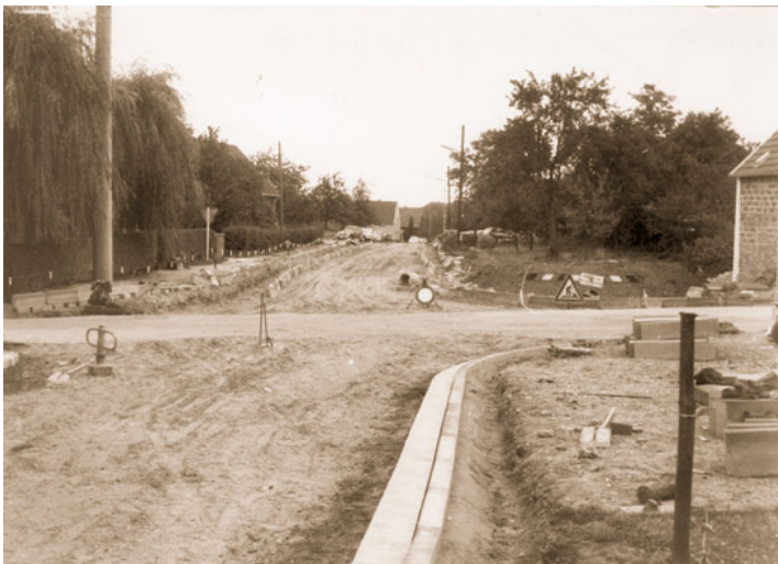
Abb. 5: Ein neues Verkehrsgefühl bahnte sich auch in Windhausen an. Hier die im Bau befindliche Kreuzung Windhausener-/Hasenbuschstraße. Foto: Stadt
