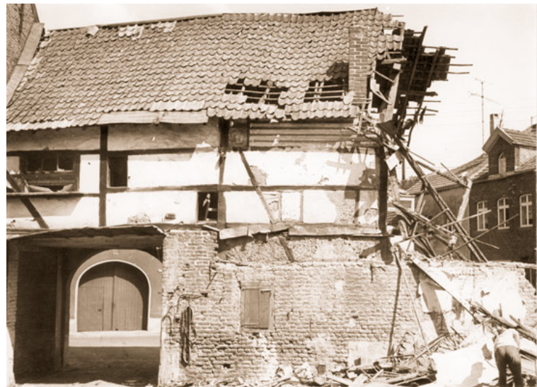
Abb. 12: Abbruch des Hauses Nievelstein, Ecke Talsstraße/Burgstraße, weil die Straßenführung der Quäkergracht und der Talstraße wegen eines höheren Verkehrsaufkommens geändert werden musste. Foto: Stadt
