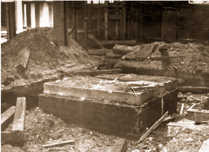
Abb. 1: Im Bild der berühmte "Deckel", der nach der Schließung eines Bergwerks "drauf gemacht" wird. Hier der verfüllte Schachtbereich der ehemaligen Zeche Carolus-Magnus. Foto: Carolus-Magnus
