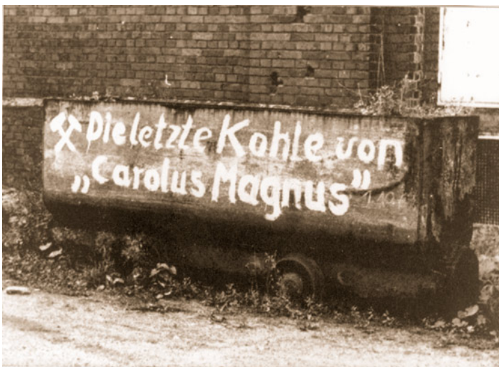
Abb. 12: Die letzte Kohlenlore der Gewerkschaft Carolus-Magnus. Eines der vielen äußerlich sichtbaren Zeichen vom Ende des Bergbaus in Übach-Palenberg.
