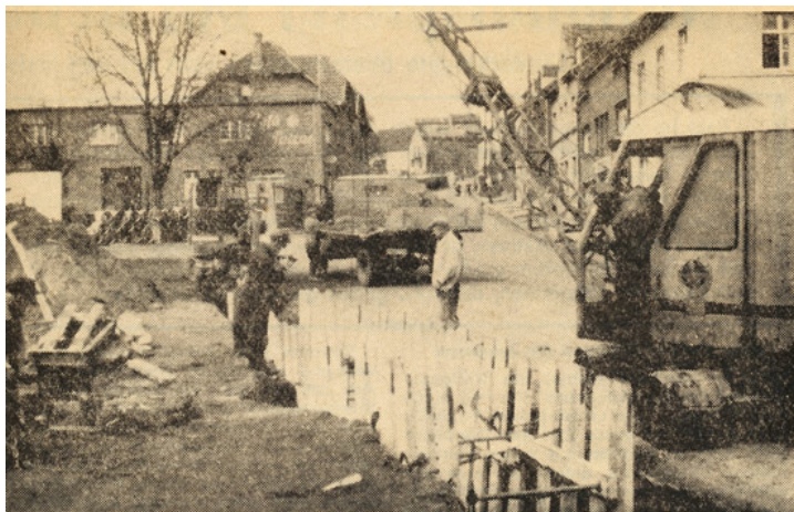
Marienberg erhält jetzt auch eine Kanalisation Unser Bild zeigt die Arbeiten in der Marienstraße. Die Rohre werden hier an den Straßenrändern verlegt. Ein Vorteil: Denn die Straße wird nicht in der Mitte aufgerissen und der Verkehr kann in beiden Richtungen weiterfließen. Ueber den Abfluß brauchen sich die Marienberger keine Sorge zu machen. Der Ort liegt an einem Berghang und von der Höhe bis zum Tal beträgt das Gefälle etwa 14 Prozent. (Foto: esa)
