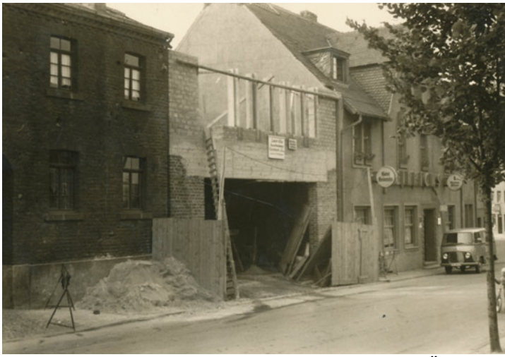
Abb. 10: Baustelle der entstehenden Festhalle in Übach. Foto: Stadt
