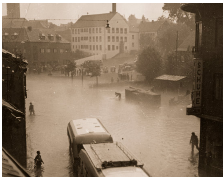
Abb. 9: Wieder "Land unter" auf dem Rathausplatz in Übach. Die Rufe nach einem dauerhaften Hochwasserschutz wurden immer lauter. Foto: Stadt
