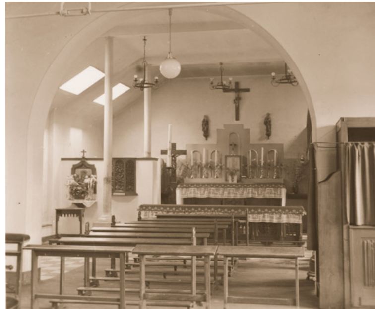
Abb. 5: Die kath. Notkirche in Übach. Sie sollte ihren Zweck erfüllt haben, wenn die neue kath. Kirche in Übach im Mai fertig würde. Foto: Heinen
