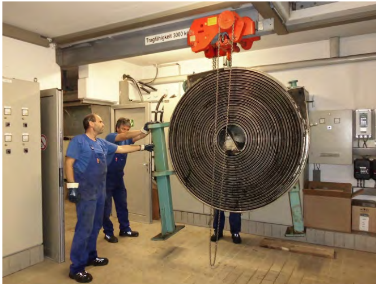
Ausbau eines alten und defekten Wärmetauschers
