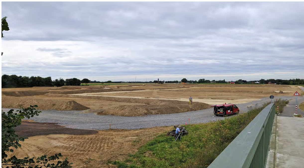
Erstellung der Baustraßen Oerather Mühlenfeld-Süd
