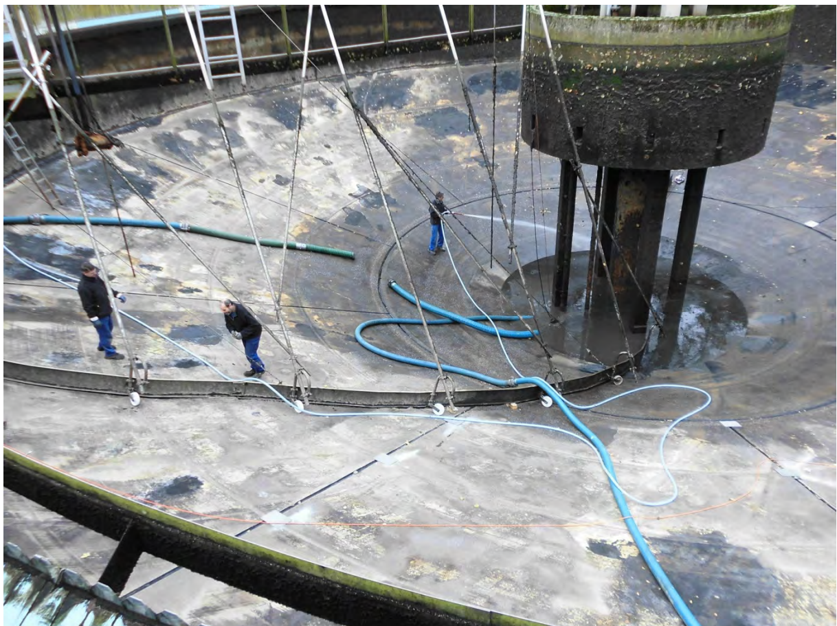
Mitarbeiter der ARA bei Reparatur- und Reinigungsarbeiten im NKB III
