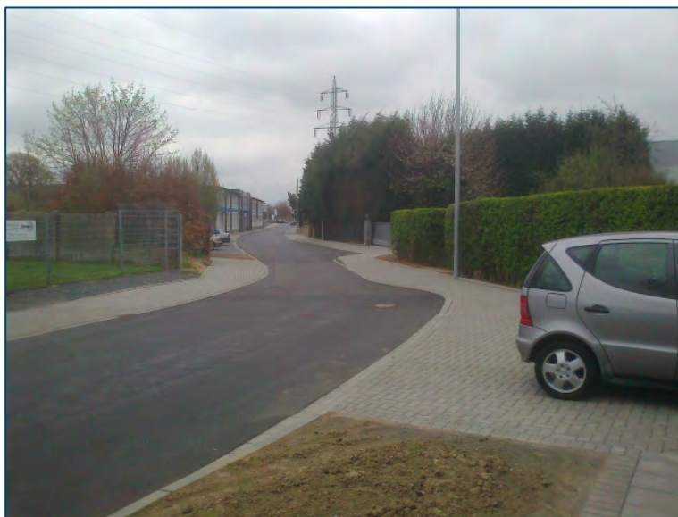
Fertig ausgebaute Bereiche Straße/ Nebenanlagen und Zufahrten
