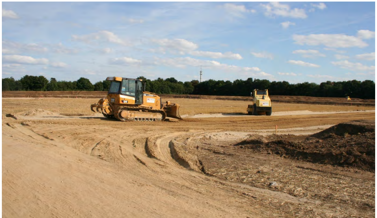
Erschließungsarbeiten Oerather Mühlenfeld-Süd
