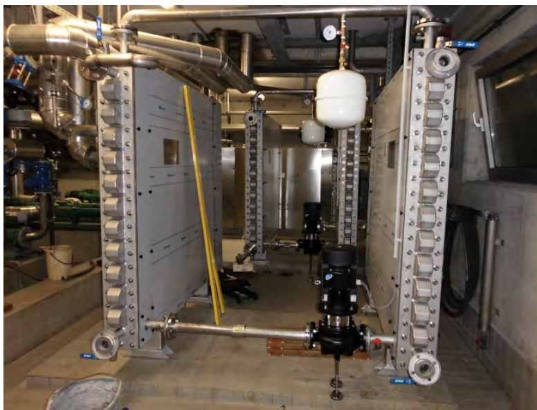
Einbau von insgesamt vier neuen Wärmetauschern inklusive Fertigung und Herstellung von Armaturen und Steuertechnik durch das Personal der ARA.
