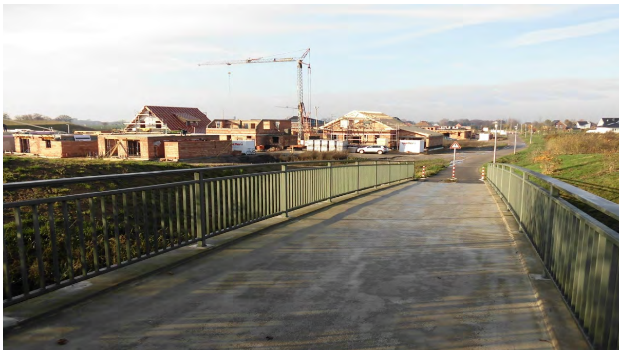
Beginn der Hausbauten Oerather Mühlenfeld-Süd
