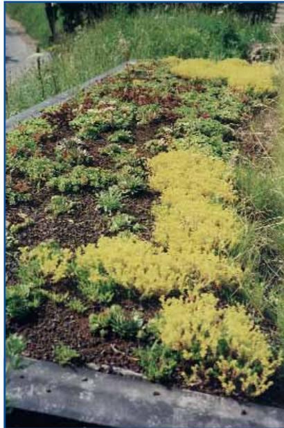
hölzen ausgebildet. Die Nutzungs- und Gestaltungsvielfalt ist im Vergleich zu aufwendigen Intensivbegrünungen eingeschränkt. Die verwendeten Pflanzen stellen geringe Ansprüche an den Schichtaufbau sowie an Wasser- und Nährstoffversorgung. Pflegemaßnahmen sind in reduziertem Umfang erforderlich. Die Herstellungskosten sind niedriger als bei aufwendigen Intensivbegrünungen.
