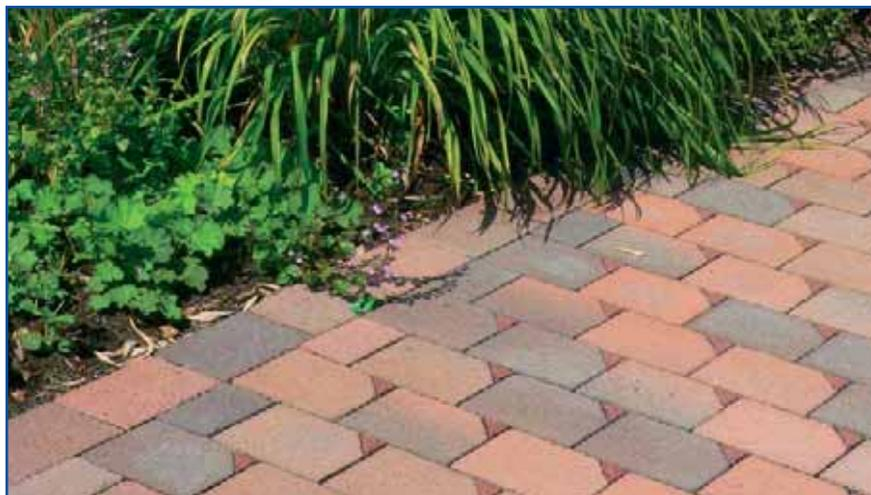
*Parkplatzbefestigung aus versickerungsfähigem Pflaster*
