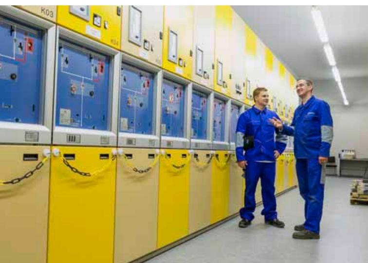
**» In einer Mittelspannungsnetzstation kommt der Strom mit 20.000 Volt an. Wer hier arbeiten möchte, muss gut ausgebildet sein.«**
