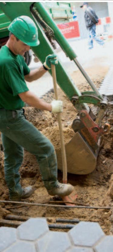
Geordnet und griffbereit: Verkehrsschilder warten auf ihren Einsatz auf der Baustelle. (Foto oben) Wo bereits Leitungen liegen, wird mit der Schaufel von Hand ausgeschachtet (links).
