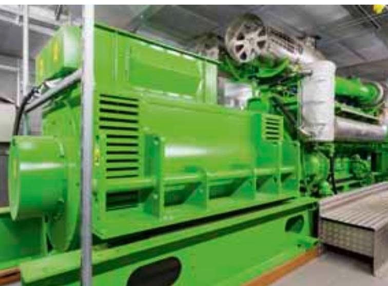
1,99 Megawatt leistet das BHKW. Innerhalb von nur neun Monaten konnte es in Betrieb gehen. Die etwa 400 Grad warmen Motorabgase werden für die Dampferzeugung in der Produktion verwendet.
