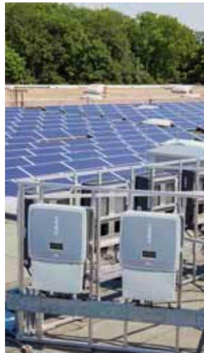
Die PV-Anlage auf dem Dach erzeugt 275.000 Kilowattstunden im Jahr, die direkt ins Netz gespeist werden.
