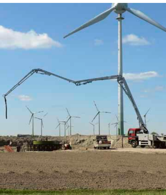
Die beiden ersten Windparks von Green GECCO ersparen der Umwelt 60.000 Tonnen Kohlendioxid jährlich.
