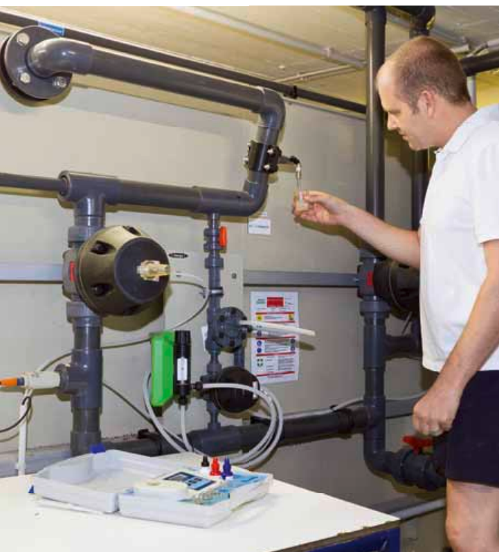
Jede Woche prüft Armin Ganster den Chlorgehalt. Dafür zieht er aus dem Vorratsbehälter Wasserproben.
