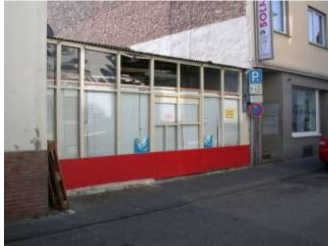
Abbildung 36 Eingeschossiger Behelfsbau an der Bischofstraße
