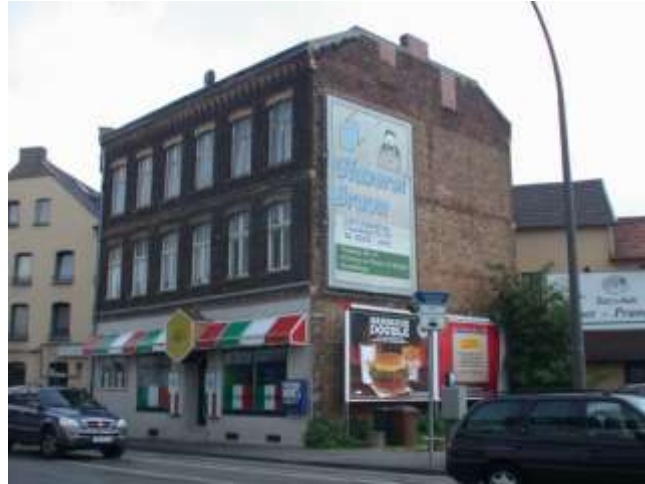
Abbildung 27 „Restbebauung“ an der Kommerner Straße
