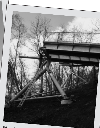
Montagearbeiten an den Tetrapoden (Stützen des Schwebesteseges)
