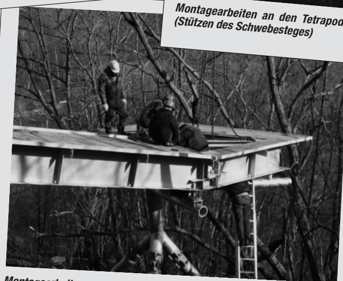
Montagearbeiten am Schwebesteg
