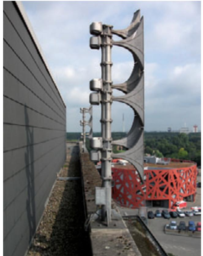
Bild (54) Eine moderne Sirenenanlage auf dem Dach der Feuer- und Rettungswache 5 (BfK)
